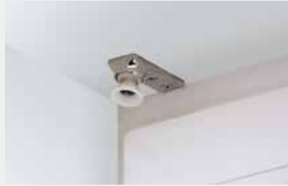
Sichtbar ist nur noch das Gelenklager mit Trichter, ...
