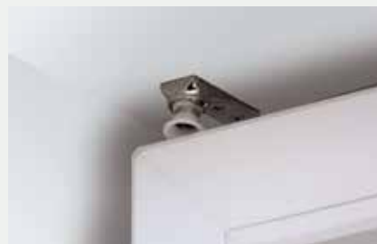
... der durch seine geringe Bauhöhe die Bedienung des Fensters nicht beeinträchtigt.
